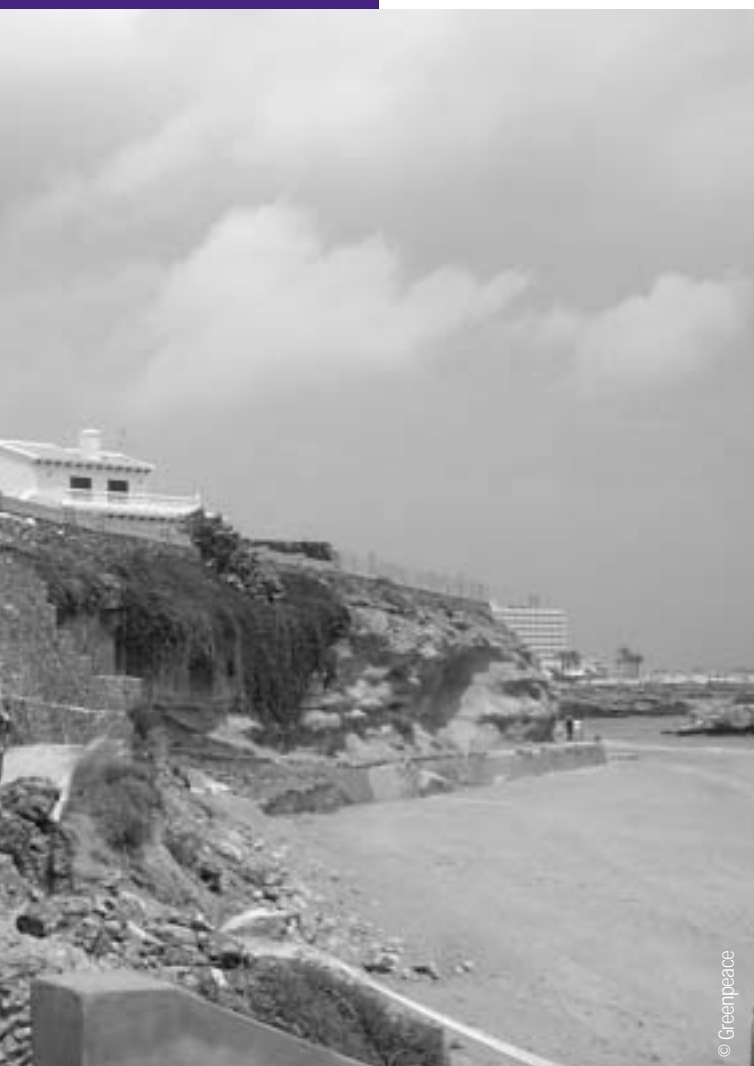
Daños en Punta de la Horadada, Alicante.
