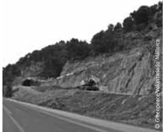
Obras de construcción del túnel para el nuevo acceso al Port de Sóller (Mallorca).
