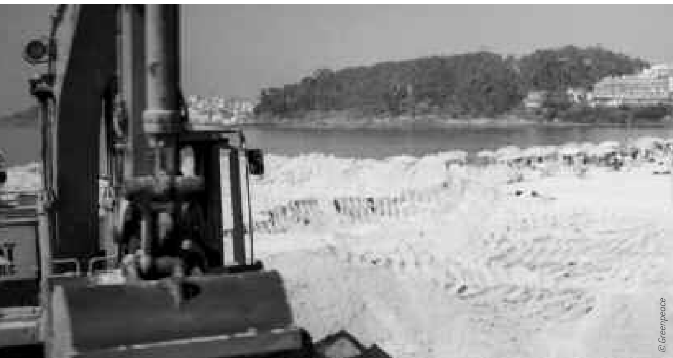
Máquinas trabajando en la regeneración artificial de la playa de Silgar, Sanxenxo (Galicia).
