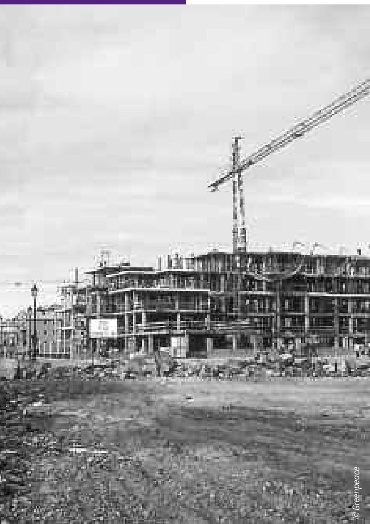
Urbanización en Isla Canela (Huelva), construida en zona inundable.
