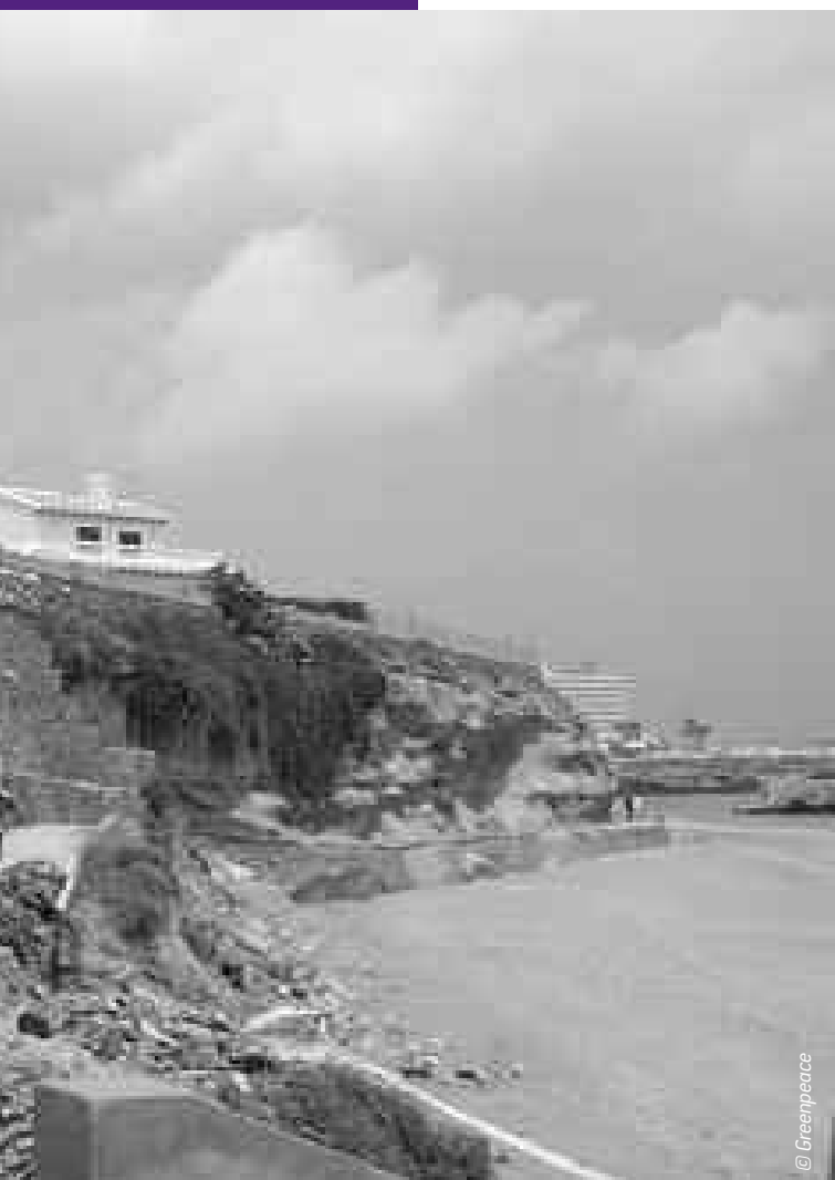
Daños en Punta de la Horadada, Alicante.
