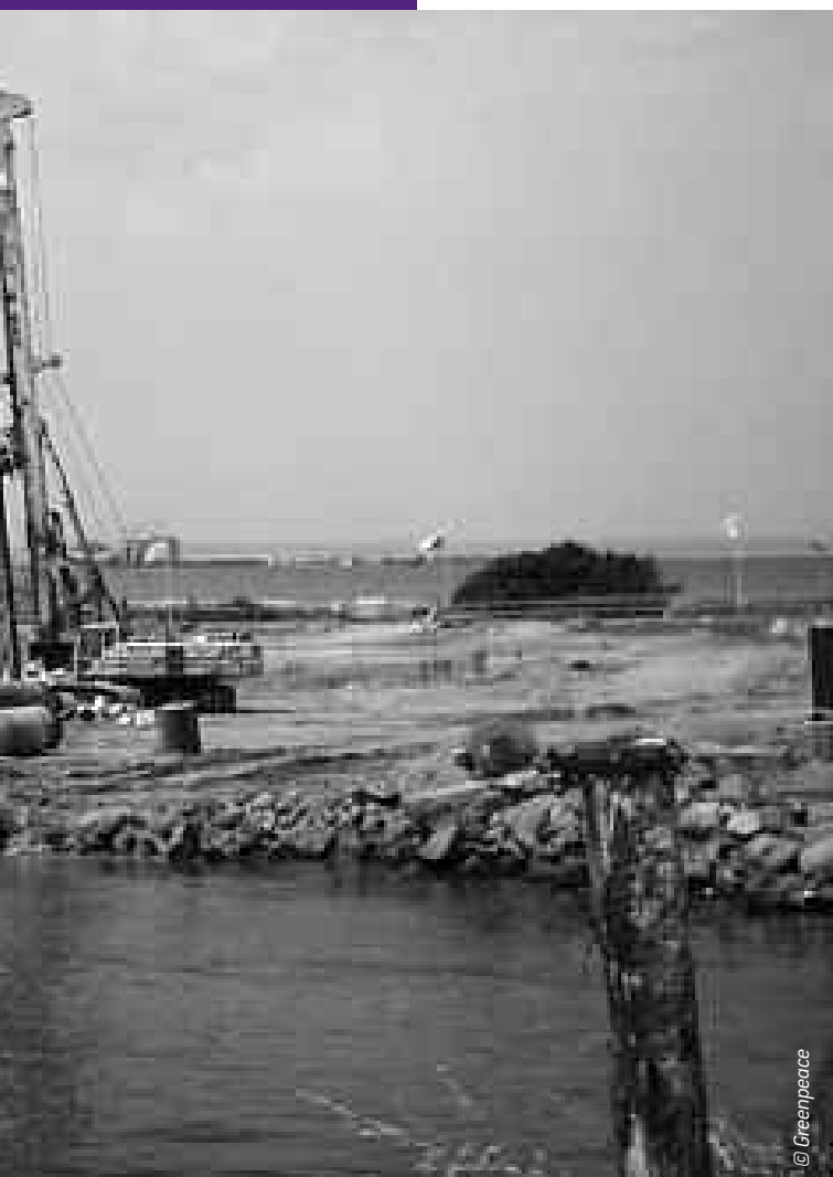
Construcciones en La Manga del Mar Menor.
