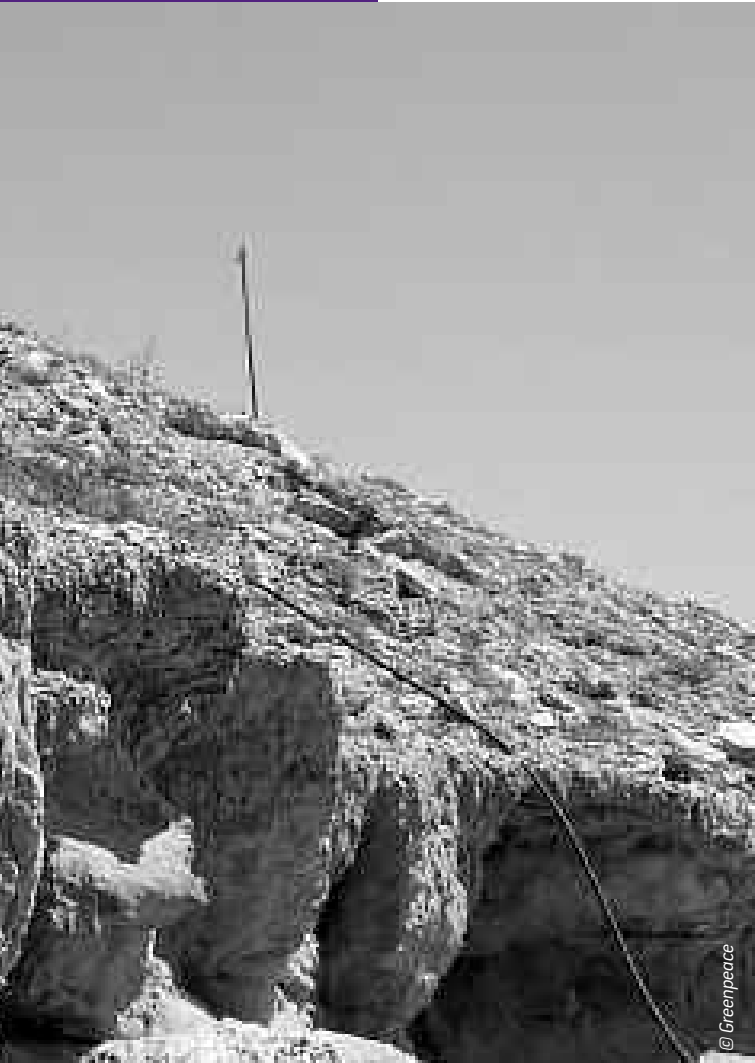
Destrucción a pie de playa. Rocamar, (Comunidad Valenciana).
