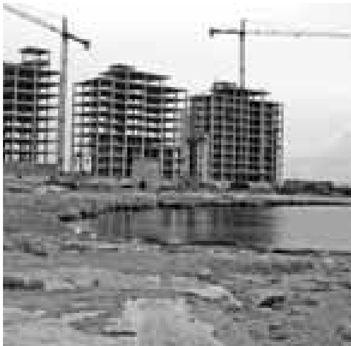
NUEVOS EDIFICIOS EN CONSTRUCCIÓN EN LA VENEZIOLA, AL NORTE DE LA MANGA DEL MAR MENOR © GREENPEACE-GL MURCIA
