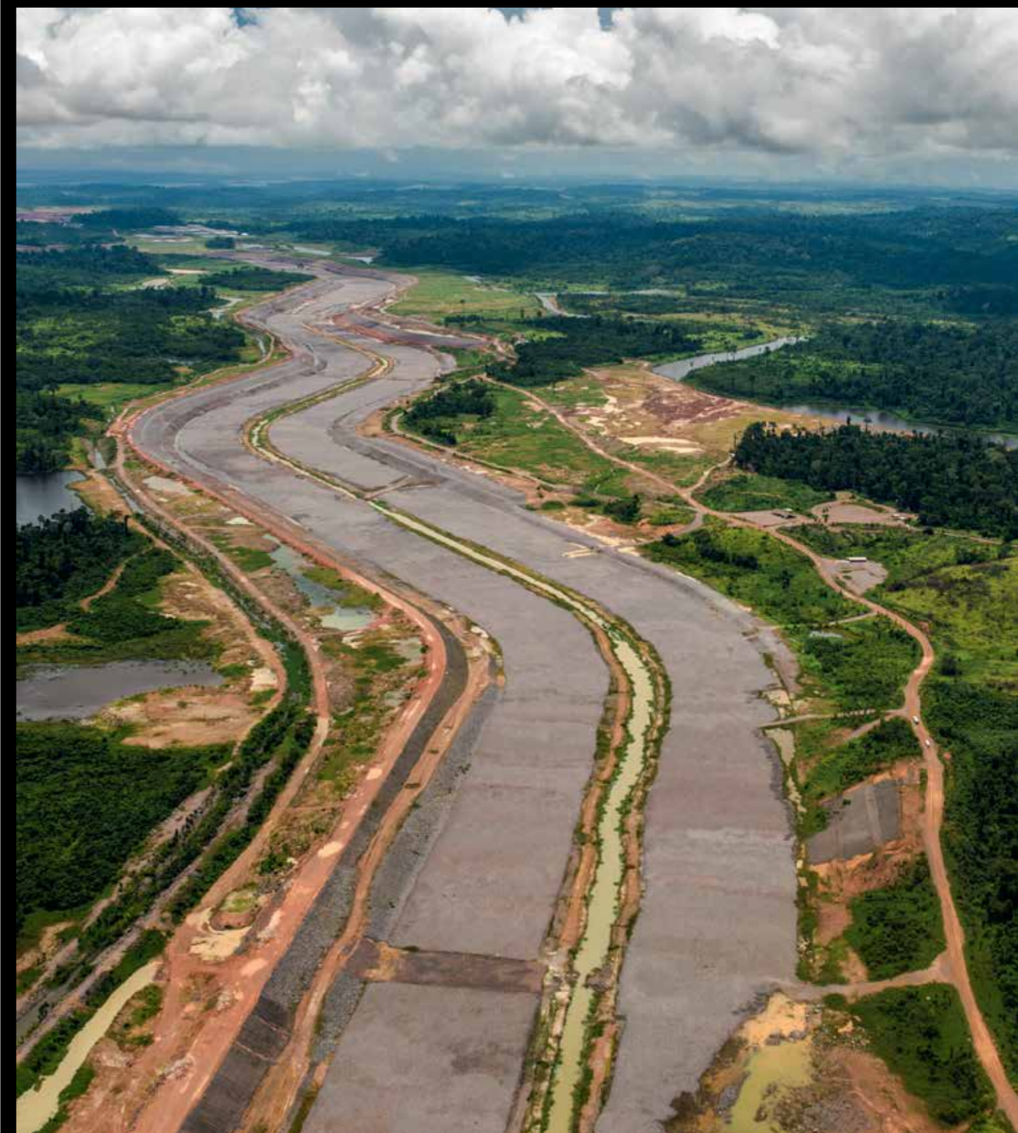
Vista aérea de las obras de la presa hidroeléctrica de Belo Monte. © Fábio Nascimento/Greenpeace
