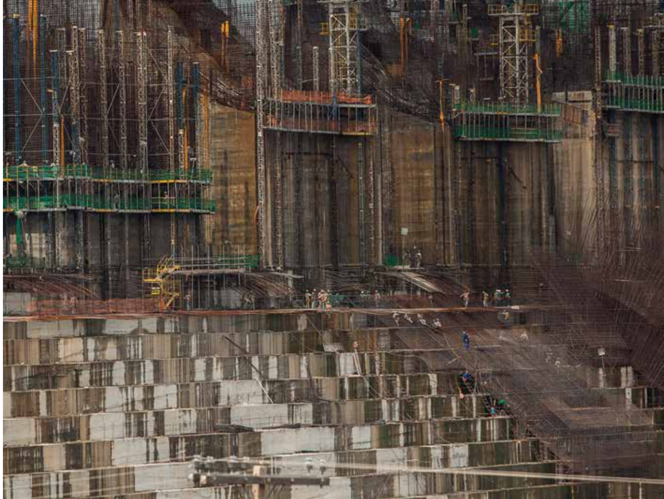
Obras de construcción del complejo hidroeléctrico de Belo Monte, estado de Pará. © Carol Quintanilha/Greenpeace
