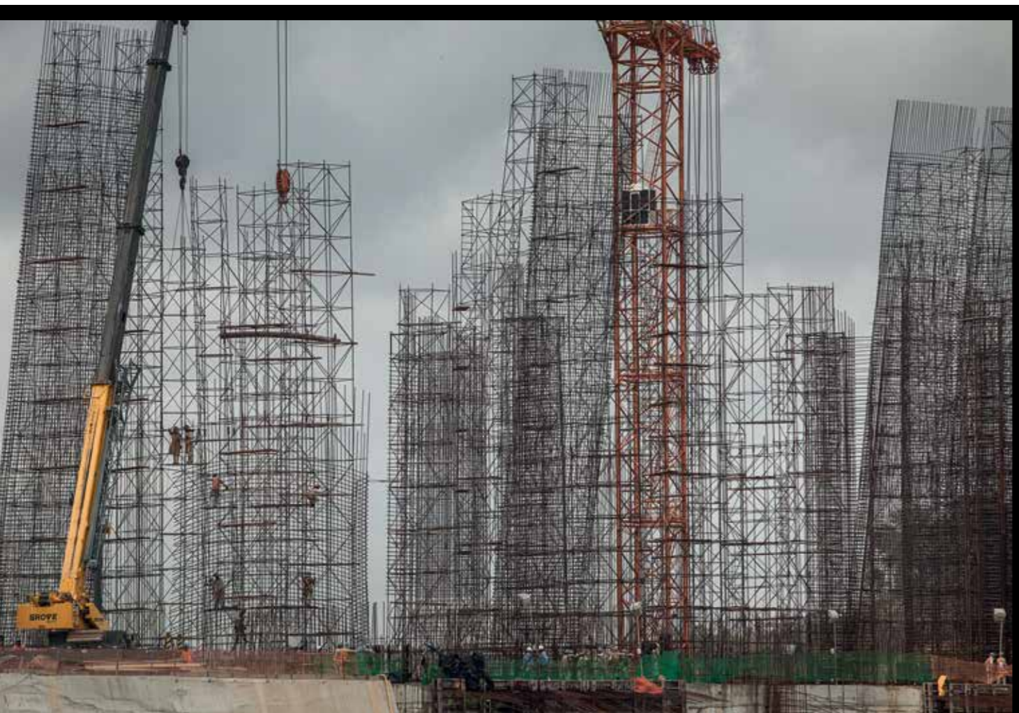
Obras de construcción del complejo hidroeléctrico de Belo Monte, estado de Pará. © Carol Quintanilha/Greenpeace
