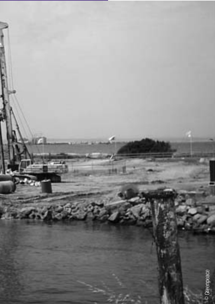
Construcciones en La Manga del Mar Menor.
