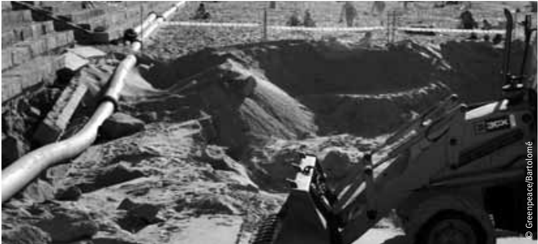
Maquinaria trabajando en la playa de Santa Cristina, A Coruña.
