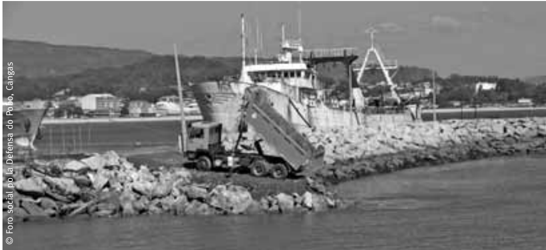
Rellenos en un dique de Cangas do Morrazo, Pontevedra.
