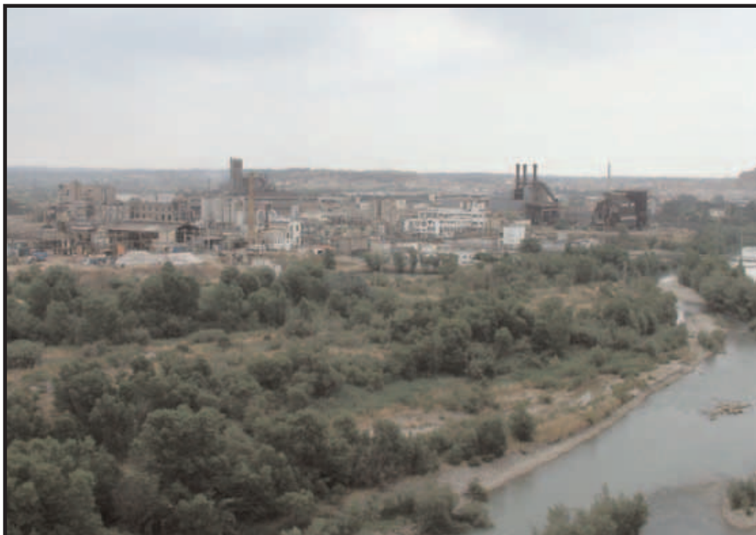
Vista general de las instalaciones de Montecinca, S.A.
