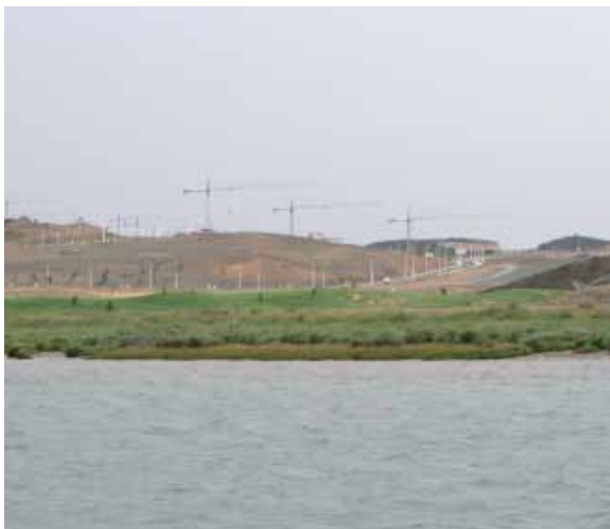
Obras de Costa Esury a la orilla del Guadiana.
