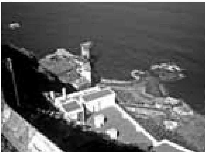
CONSTRUCCIONES EN MESA DE MAR, TACORONTE (TENERIFE)
