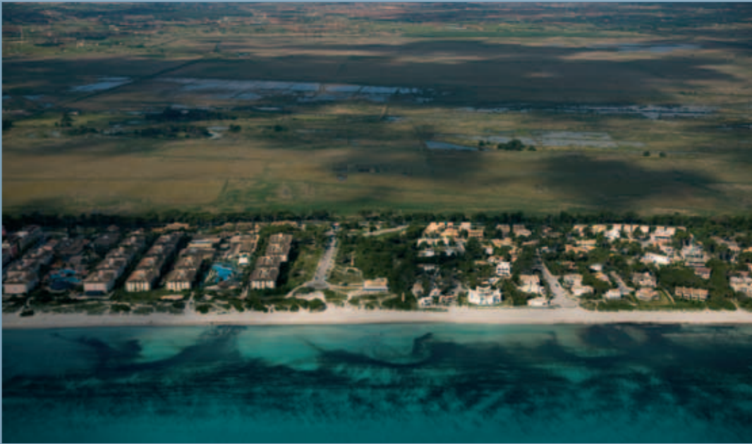
La construcción en primera línea de costa es muy frecuente en Baleares
